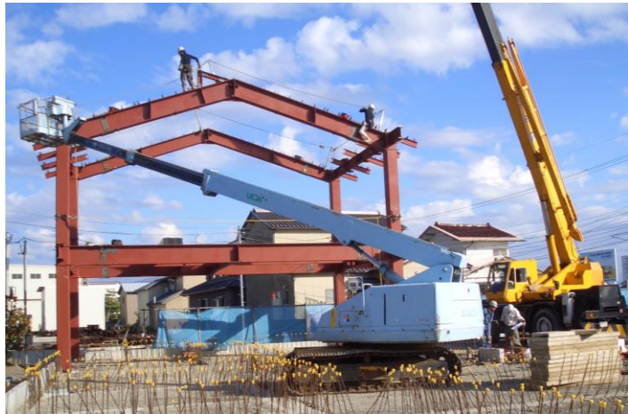
11月5日、秋晴れの下での鉄骨建て方となりました。
